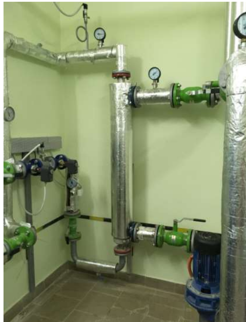
Рисунок 9 - Элементы схемы ИТП на базе кожухотрубных теплообменных аппаратов
